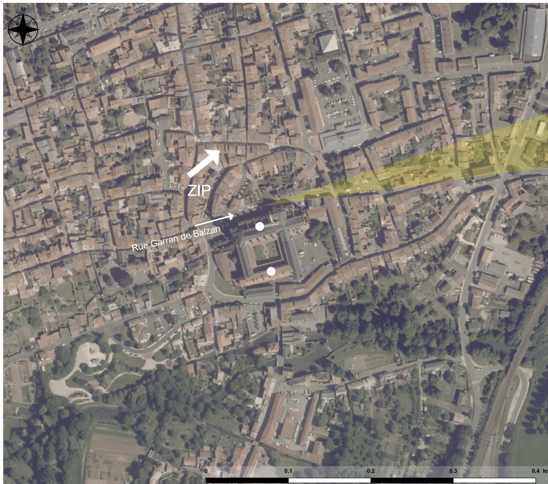
Fig. 107 : Vue aérienne rapprochée du contexte paysager du monument
